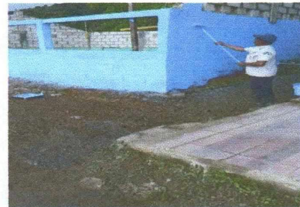
Foto 4: Sustitución de pared de cocina
