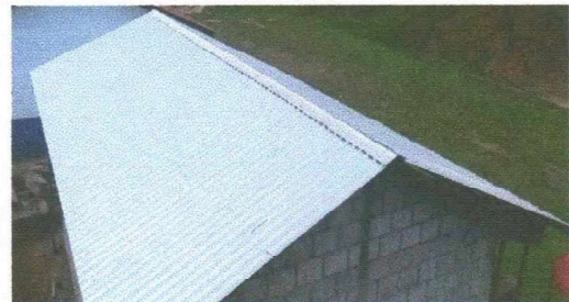
Foto 6: Sustitución de techo en cocina
