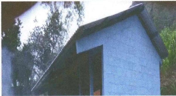
Foto 3: Sustitución de techo y lamina en area de cocina
